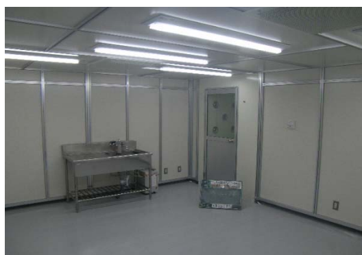
産業技術センター（内部）
